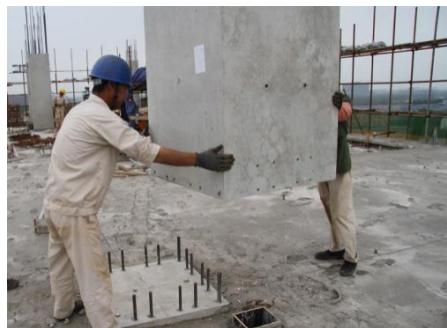
图3 预制柱吊装施工
